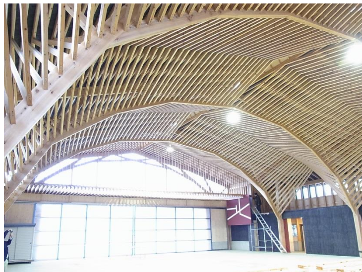
(北沢建築本社工場棟)
