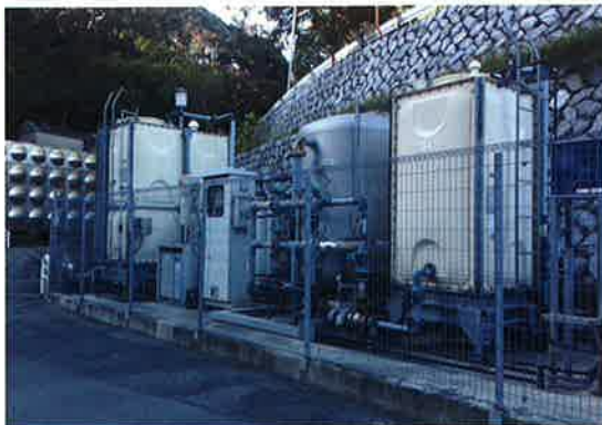
耐震改修工事を契機に主要設備を更新し災害対応力を強化
