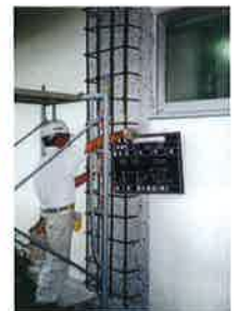
柱のRC巻き立て補強
