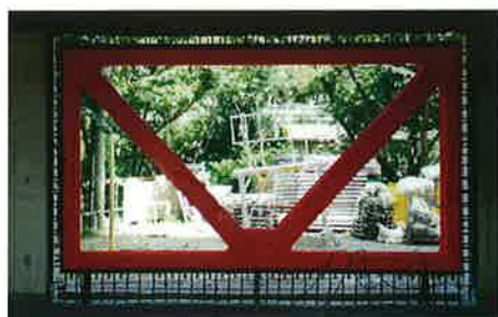
H型鋼ブレースによる補強
