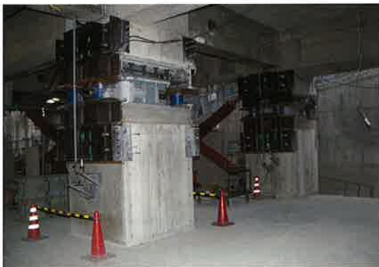
施設運営への影響が少ない免震工法
