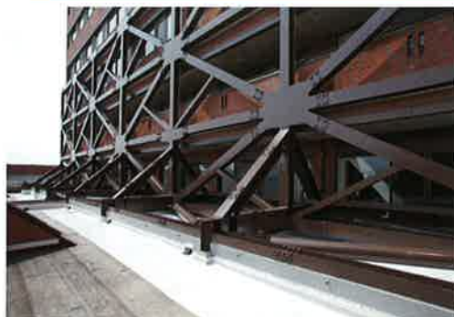
内部補強で狭くなるところの手前に枠組み鉄骨ブレースを利用した棚を設置
