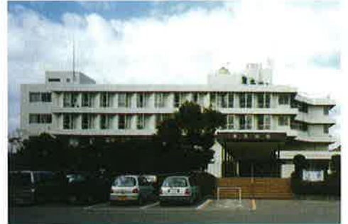
外観は竣工当初の意匠を継承、補強は目立たない
