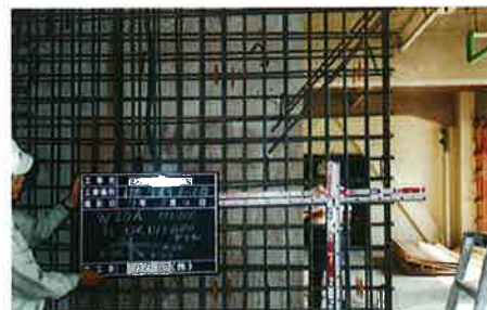
RC壁による補強
