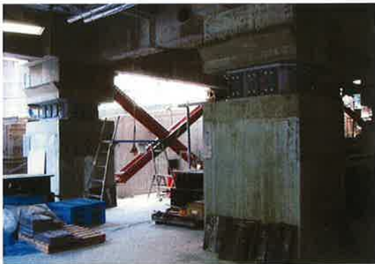
柱頭免震工事
