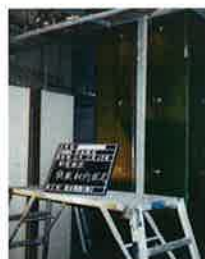
柱の鋼板巻き立て補強
