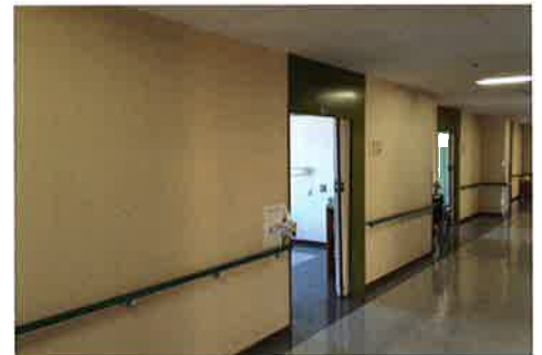
耐震壁補強工事とあわせて病棟の内装のリニューアルを実施
