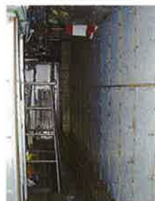
グラウトによる壁新設部(鉄板型枠・鉄筋)
