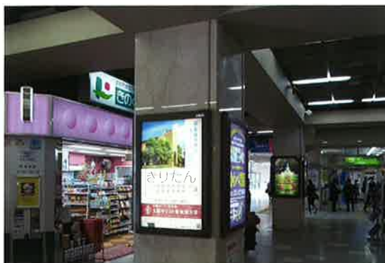
補強した柱を広報スペースに活用
