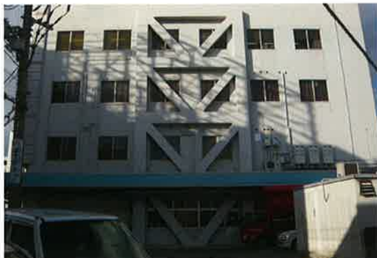
外部鋼管ブレースによる補強
