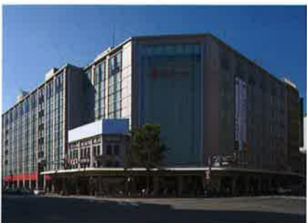
設計時の意匠を生かしつつ、フレーム補強にあわせてガラスを多用し明るい雰囲気に
