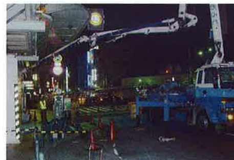
夜間に工事を実施し営業を継続
